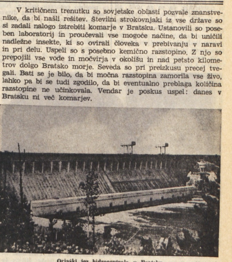
Orjaški jez hidrocentrala v Bratsku
