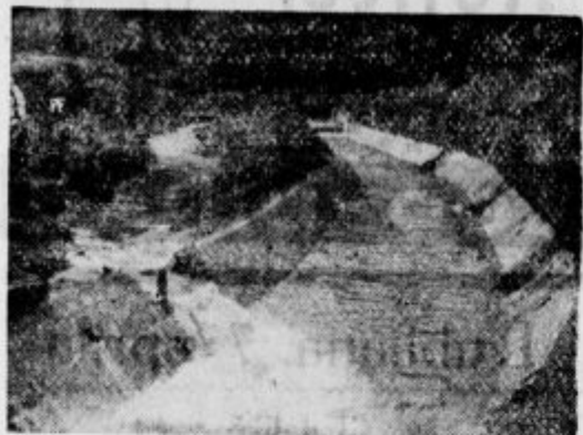
Dolgi in lepo zgrajen odtočni kanal v Globočcu. V ozadju zajetje izvirka.
