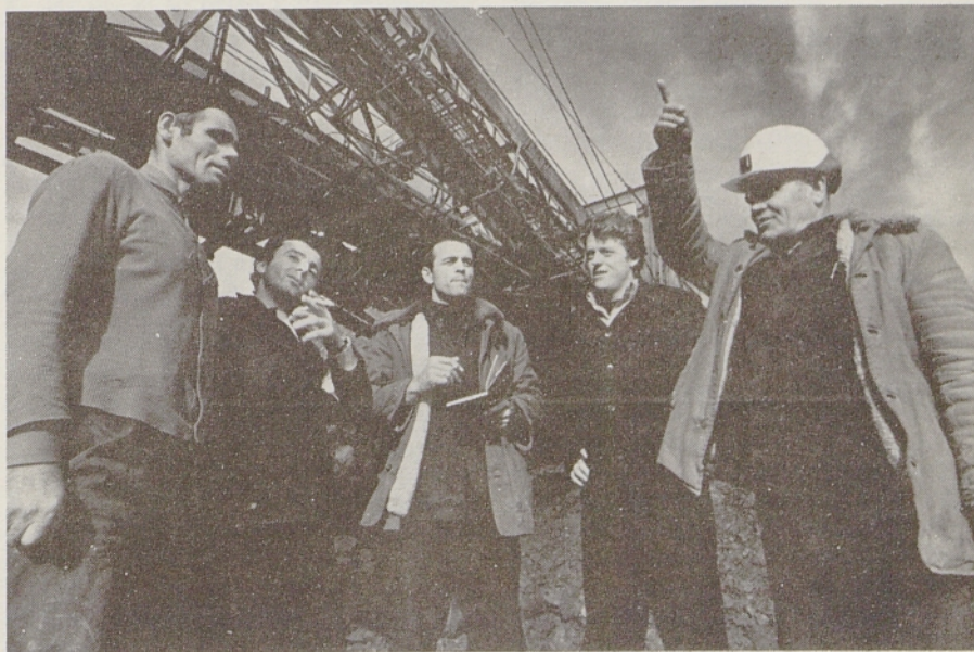
Na gradbišču (foto: Miško Kranjec)
