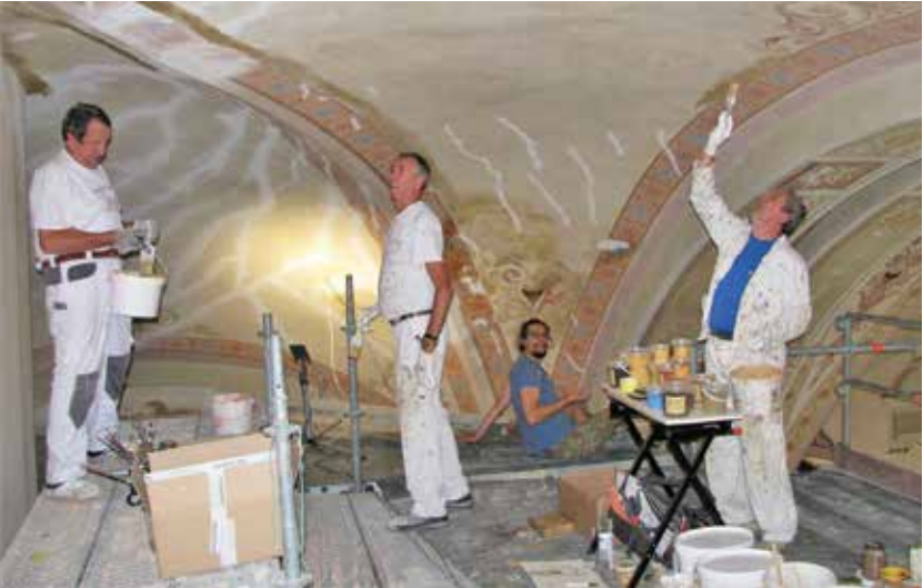
Med sanacijo stropa in sanacijo poslikav na koru
