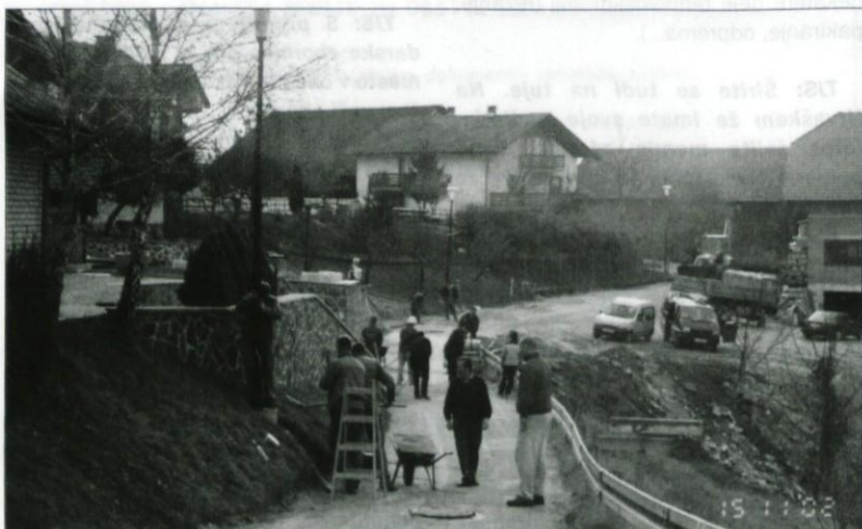
Priprave na asfaltiranje in javno razsvetlavo.
