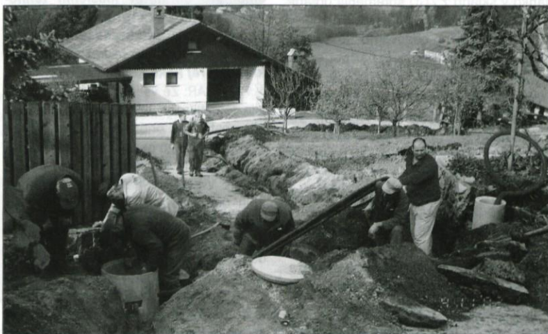
Vgraditev zaščitnih cevi za kable.
