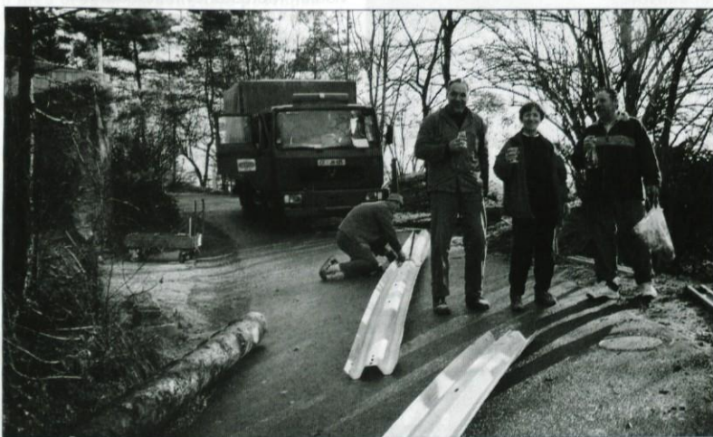
"Nadzorni" pri postavitvi varovalne ograje - vse foto Anka Fabjan.
