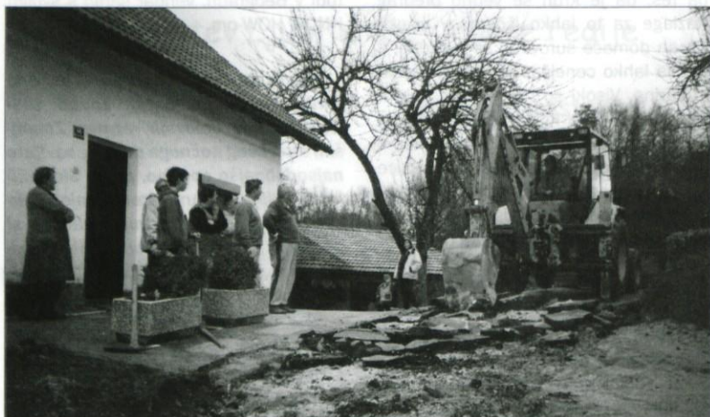
Krajani so sami pripravili cestišče za krpanje asfalta.
