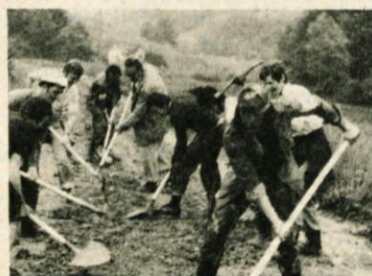
Ena izmed desetih delovnih skupin na izravnavi ceste na Vinski vrh
