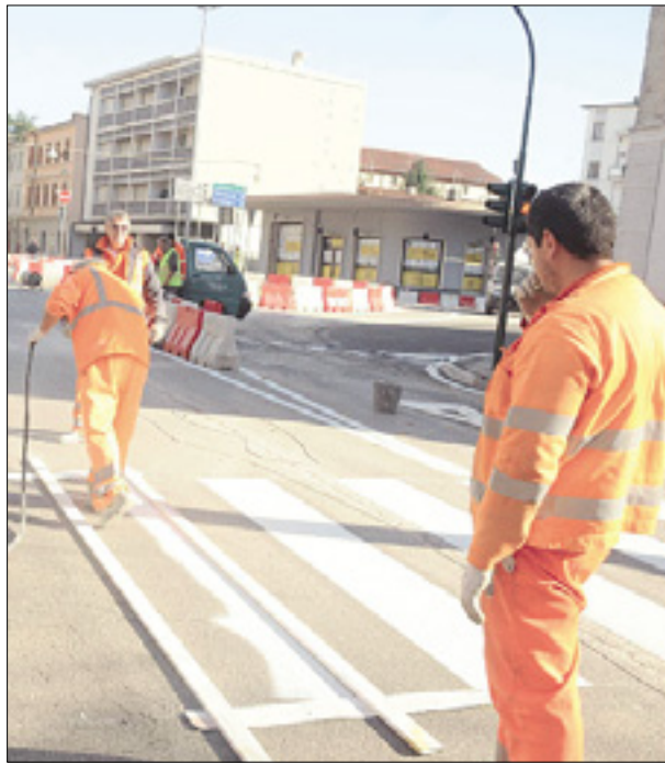
Včeraj dopoldne so zarisali prehode za pešce
