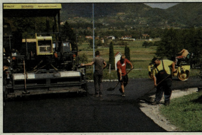
Med polaganjem finega sloja asfalta
