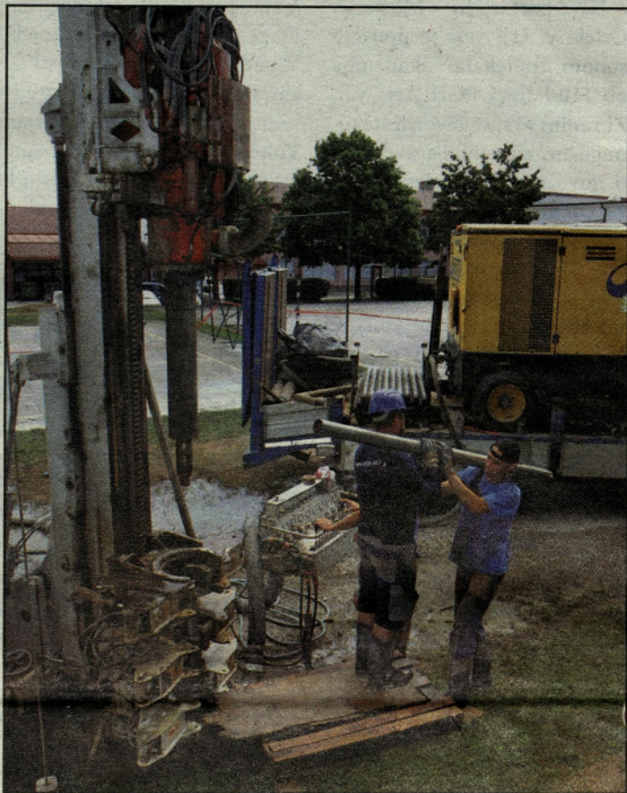
Vrtanje za namestitve sond
