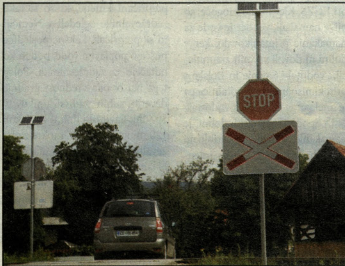
Andrejev križ, opremljen z dodatno svetlobno signalizacijo s solarnim napajanjem
