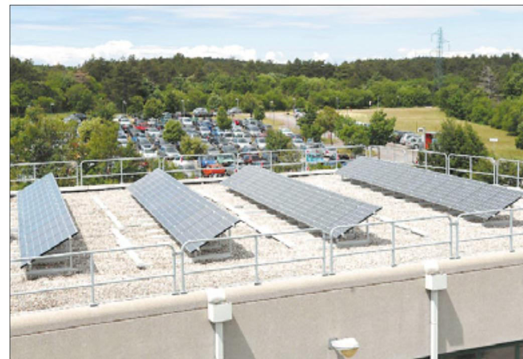
Na strehi poslopja W je nameščen namestila fotovoltaičen solarni sistem
