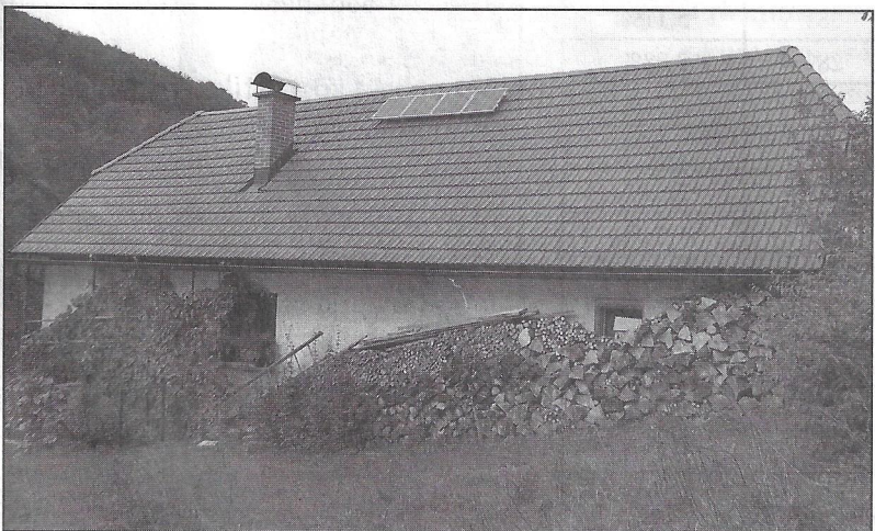
Solarni moduli na strehi so povezani s hibridno napajalno napravo v kleti hiše
