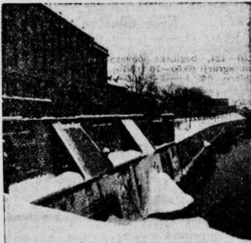
Lesene drče, po katerih sneg hitro zdrči v vodo in se ne gromadi v kupe.
