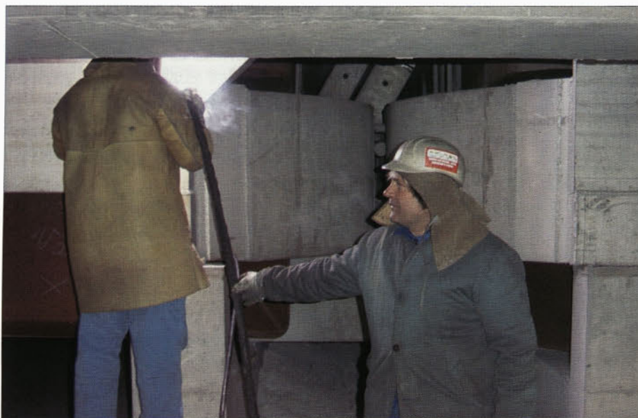
Popravila zvarov katodnih tokovodnikov v starem delu elektrolize C
