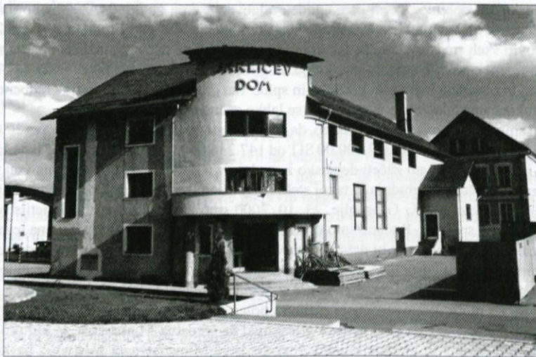
Jakličev dom tik pred začetkom del, poletje 2000, foto: Ivan Grandovec.
