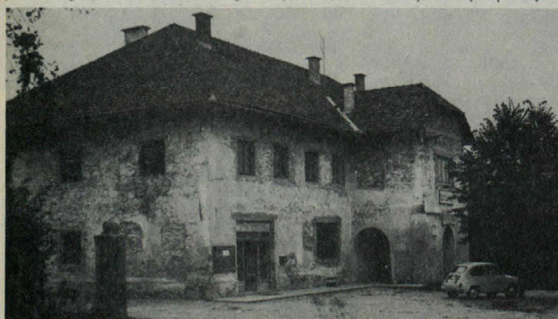
Zadrugi dom v Predgradu, na njem sta 2 spominski plošči, padlim gasilcem in zbirnemu centru VII. korpusa.
