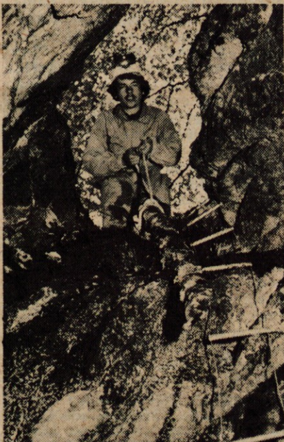
Brez improvizacije seveda ne gre: Stane Česnik po vrvi spušča v jašek lesen kol, s katerim bodo njegovi tovariši podprli krhljive apnenčaste skale in preprečili nevarno padanje skal.
