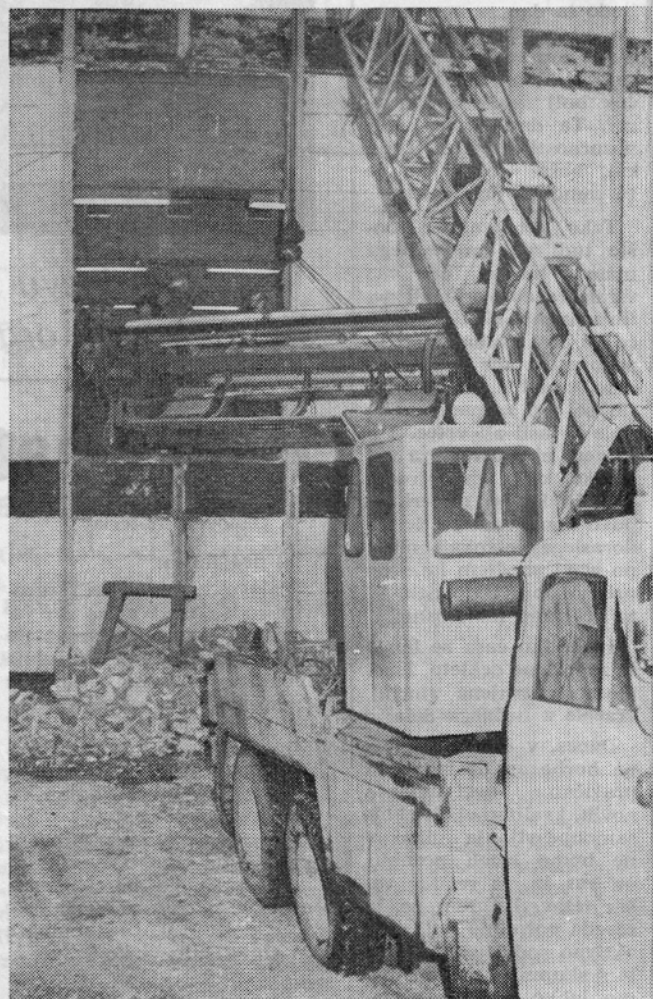
Transport Picanol tkalskih strojev v drugo etažo nove tkalnice
