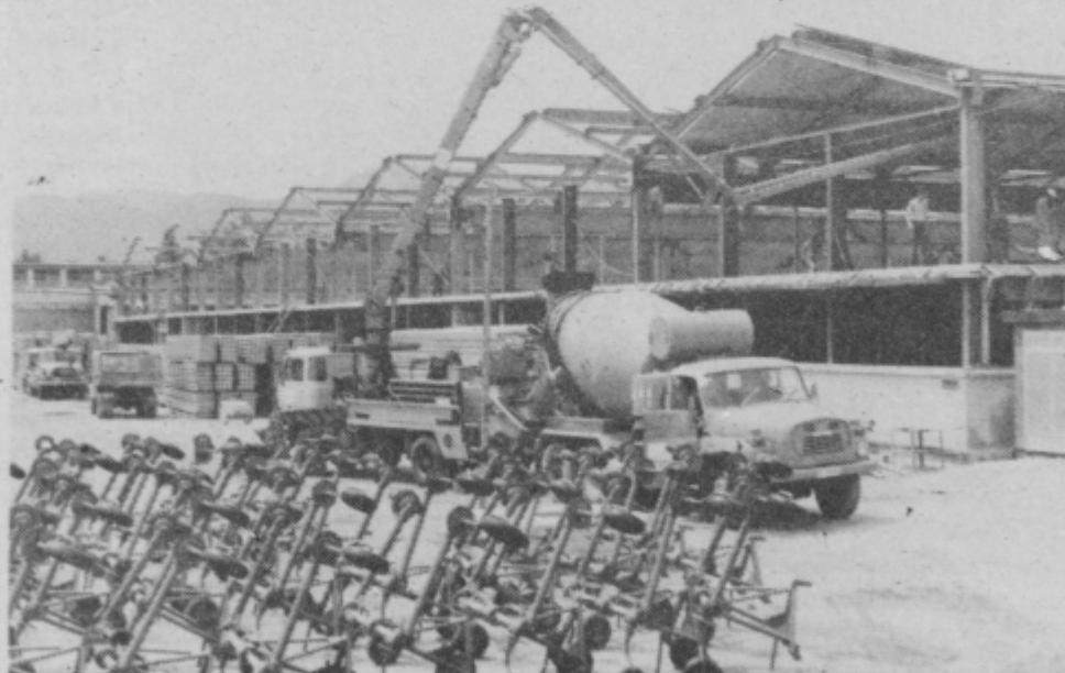
Gradnja nove tovarne Sip v Sempetru poteka po načrtu. Proizvodnja v njej bo dvakrat večja kot sedaj, na novo bodo zaposlili 350 delavcev, sicer pa ostaja Sip tudi v naslednjem srednjeročnem obdobju glavni nosilec razvoja kovinsko predelovalne industrije.
