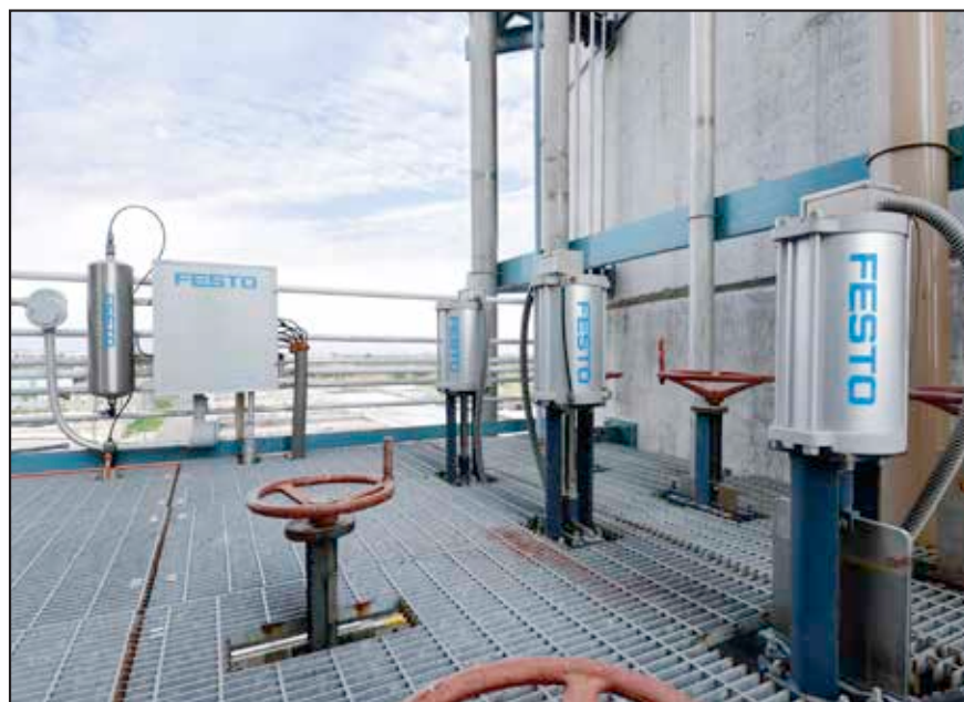
Slika 10. Pnevmatični pogoni za odpiranje in zapiranje procesnih ventilov (zapahov in loput) imajo pomembno prednost pred električnimi: trpežnost, dolge intervale vzdrževanja in varnost pri preobremenitvi. (Foto: Festo AG & Co. KG)
