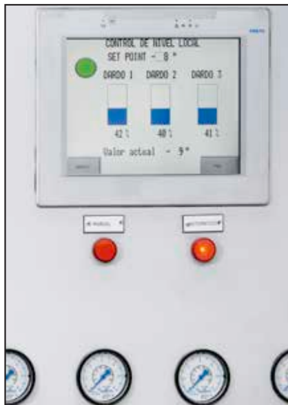
Slika 9. Krmilna omarica s prikazovalnikom stanja ventilov (Foto: Festo AG & Co. KG)
