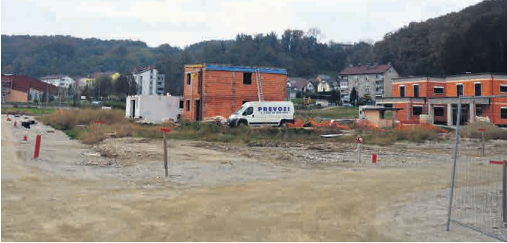
Za izgradnjo pločnikov in javne razsvetljave ter asfaltiranje nosilne plasti cest v novem naselju Majšperk so na občini prejeli štiri ponudbe.
