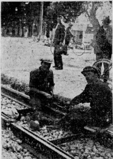
Delavca brusita in gladita že zvarjeno in oklesano tračnico.
