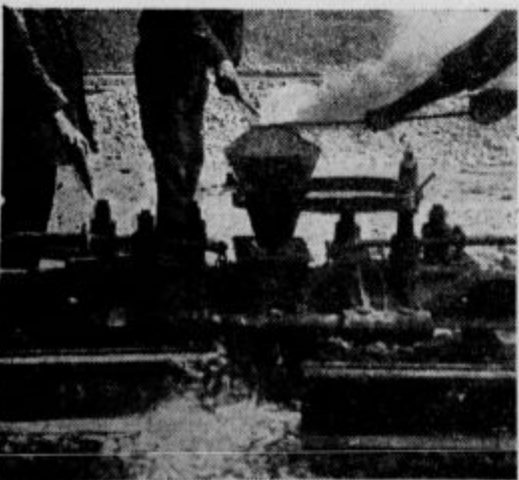
Termit gori v kotliču nad kalupom. Zadnji trenotki pred varjenjem.
