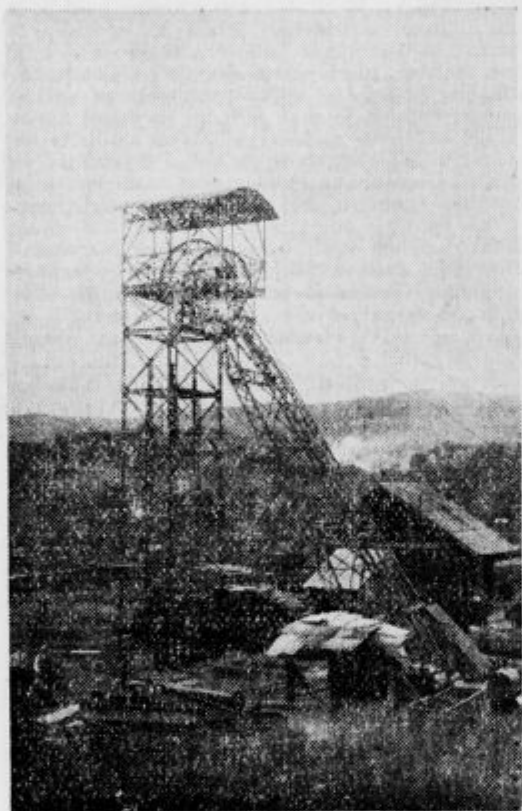
Vhod v rov »Južno okno«, katero je leta 1931 zala voda
