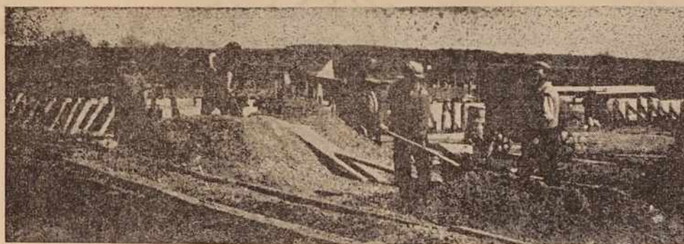
V Prosenjakovcih raste iz tal nova zgradba strojnega pletilstva, ki bo zaposlila 80 ljudi. Prebivalci Prosenjakovci in okoliških vasi pomagajo pri gradnji s prostovoljnim delom in prispevajo gradbeni material. (Berite sestavek našega sodelavca na 5. strani)
