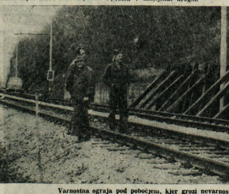
Varnostna ograja pod pobočjem, kjer grozi nevarnost zemeljskega usoda
