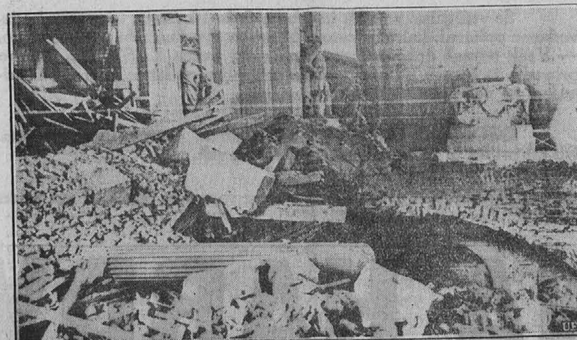
Slika nam kaže razvaline katedrale sv. Pavla v Londonu, katero so razrušile nemške bombe v zadnjem najgrozovitejšem napadu, kar so jih še vprizorili nemški napadaleci. Bomba je predrta streho in močno poškodovala notranjost, kar nam jasno kaže gornjo sliko.
