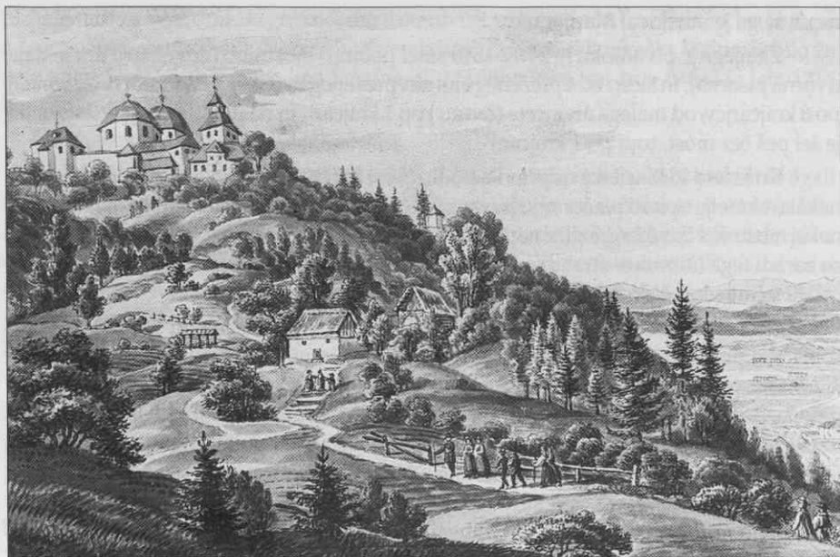
Franz Kurz zum Thurn und Goldenstein, Cerkev in ostala poslopja na Šmarni gori, gvaš, okoli leta 1850. ♦ Franz Kurz zum Thurn und Goldenstein, The church and other building on Mt. Šmarna gora, gouache, around 1850. ♦ Franz Kurz zum Thurn und Goldstein, l'Eglise et autres édifices sur Šmarna gora, gouache, vers 1850.
