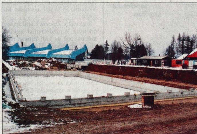
Gradbena dela na letnem kopališču v Kranju potekajo po načrtih, olimpijski bazen pa naj bi bil za preizkus pripravljen do konca aprila.
