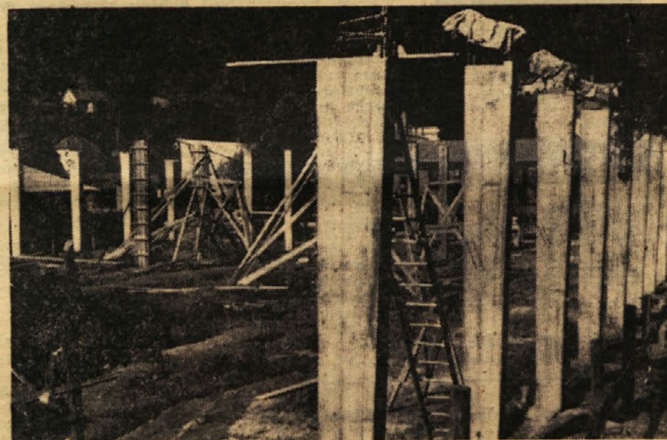
POSLOVNA ENOTA »ELEKTRO - LJUBLJANA« (prej »Elektro - Trbovlje«) je začela z gradnjo novih obratnih prostorov. Temelje zanje so že zgradili
