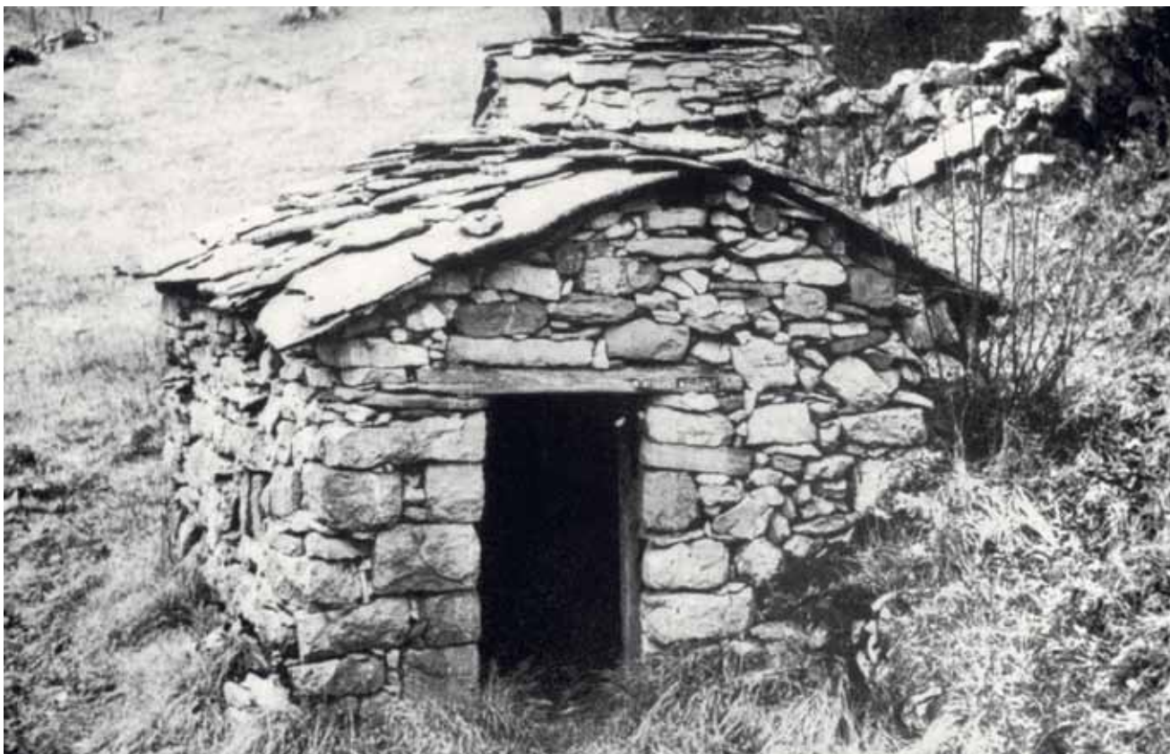
Kamnita streha "kazonov" v Benečiji FOTO: NAŠKO KRIŽNAR (Tone Cevc: Arhitekturno izročilo pastirjev, drvarjev in oglarjev na Slovenskem)
