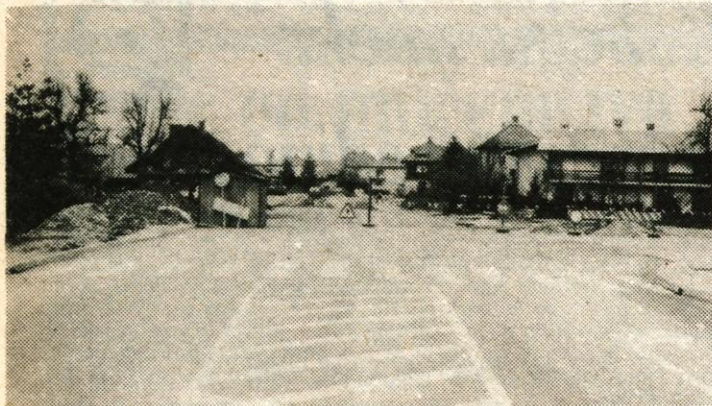
Nadaljevanje v Likozarjevi ulici — Tozd Gradnje iz Komunalnega obrtnega gradbenega podjetja Kranj v teh dneh zaključuje že lani začeta dela v nadaljevanju urejanja Likozarjeve ulice. Na odseku od križišča do Oprešnikove ulice je bilo treba vgraditi celotno elektro, ptt in ostalo inštalacijo. — A. Ž.
