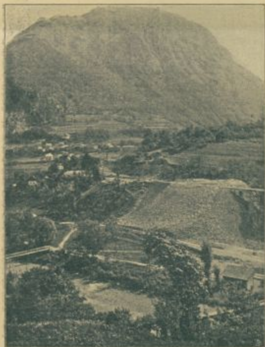
Z bohinjske železnice: Grahovo s Kojco.
