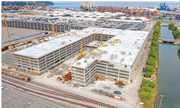
Slika 1 • Pogled na gradbišče med izgradnjo garažne hiše. Foto: arhiv Luke Koper d.d., fotograf Kristjan Stojaković
