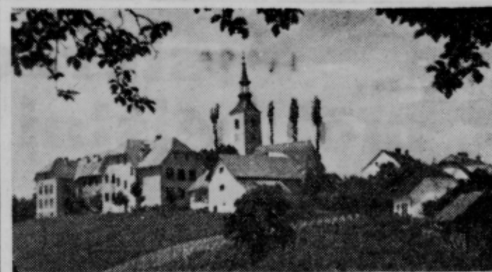
Pogled na Desternik z vzhodne strani
