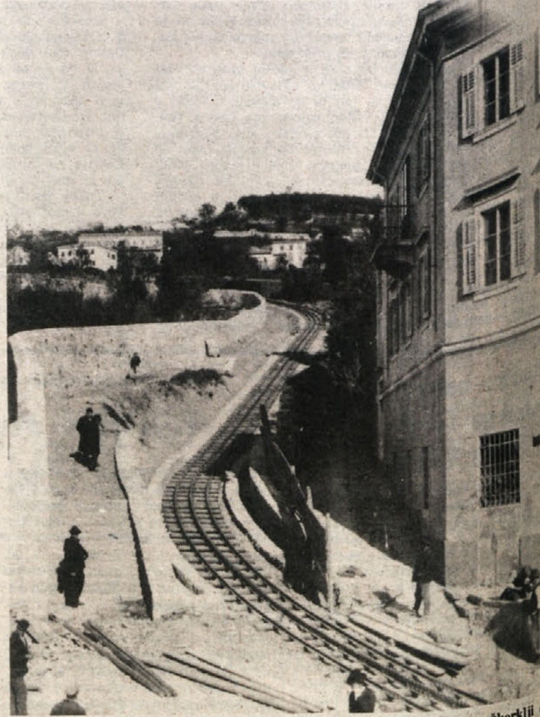
Leta 1902 se je graditev zobate železnice iz mestnega središča po Škorklji do Opčin bližala koncu, saj je jeseni tramvajski vagon že stekel po tračnicah. Po strmini se je tramvaj vzpenjal in spuščal prav s pomočjo zobatega osrednjega tira, ki je služil kot zavora. Zobate lokomotive je leta 1928 tovarna Maschinenfabrik Th. Bell & Co. iz Krienza zamenjala z vlečnim sistemom, ki je omogočal, da sta po progi istočasno vozila dva tramvaja in sicer samo v nasprotno smer
