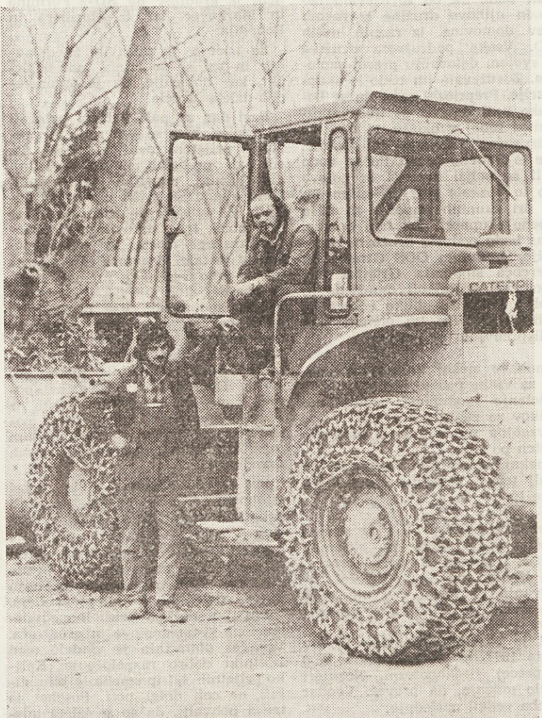
Blaž Sklepič in Karlo Zimšek na gradbišču v Baru
