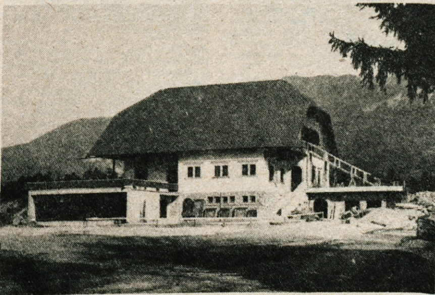
Gradnja na golf igrišču — Na golf igrišču na Bledu, ki je last Zavoda za pospeševanje in razvoj turizma Bled te dni obnavljajo restavracijo, ki jo bodo lepo in funkcionalno uredili ter tako pridobili več prenočitvenih zmogljivosti. Razen tega potekajo dela tudi na drugem objektu, ob koncu pa nameravajo urediti še okoliščino. Naložba je po predračunu vredna 30 milijonov 800.000 dinarjev. — Foto: D. Kuralt
