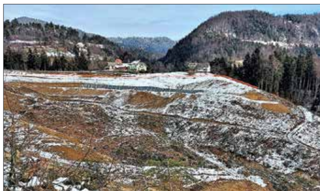
Prvo gradbišče na trasi severnega kraka 3. razvojne osi
