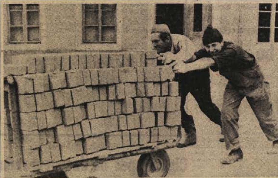
Anton Primec in Jože Franko se morata kar precej spotiti, da zrineta s surovo opeko naložen voziček do lope ali kozolca za sušenje. Po prenovitvi takega naravnega sušenja ne bo več. Opeko bodo sušili v veliki tunelski umetni sušilnici, kozolce in lope pa porušili
