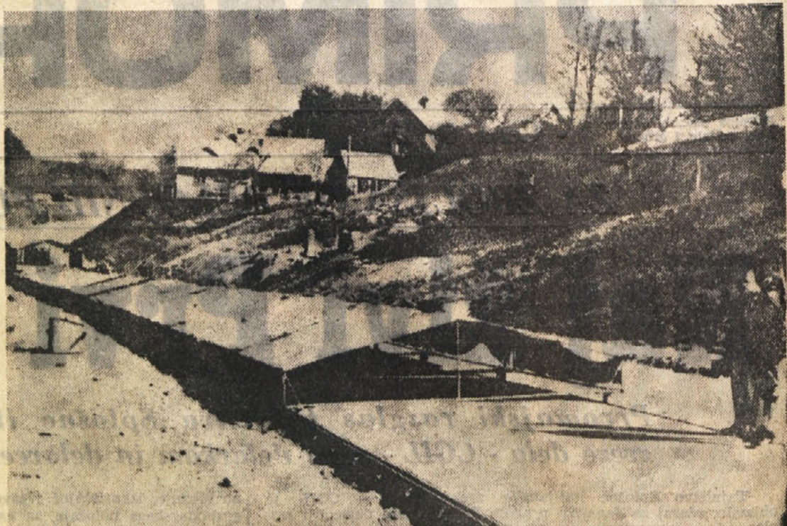
Na Gorenjskem spet betonirajo na novi cesti, ki bo presekala ovinkate okrog nerodnega brezjanskega klanca. Mogoče se homo lahko že kmalu pejal na Bled po tej cesti ter se tako izognili tistemu odseku, ki res ni bil več primeren za današnji čas in promet.
