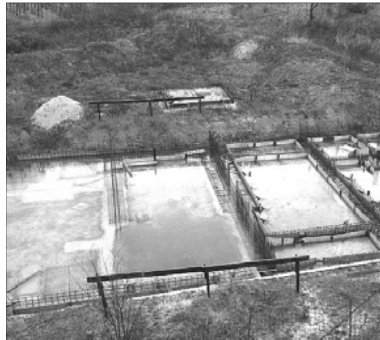
Gradbišče VDC v Novi Gorici naj bi kmalu oživel
