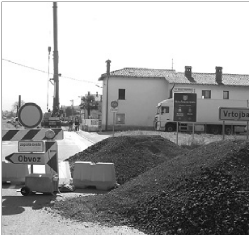
Gradnja kanalizacijskega sistema bo ohromila Vrtojbo
