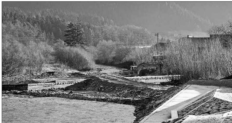
Čiščenje prodišča pod Marčinkovim jezom (Foto: Marija Lebar)
