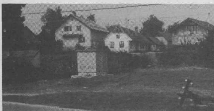
Eden novih transformatorjev v starem predelu Zaloga, ki je rešil problem nizke napetosti. V neposredni bližini bo zrasel prvi park, ki ga bodo mladinci in drugi Založani uredili s prostovoljnim delom.
