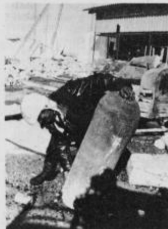
Čiščenje pogorišča, jeklenka je v ognju eksplodirala Foto: M. Ozmeč
