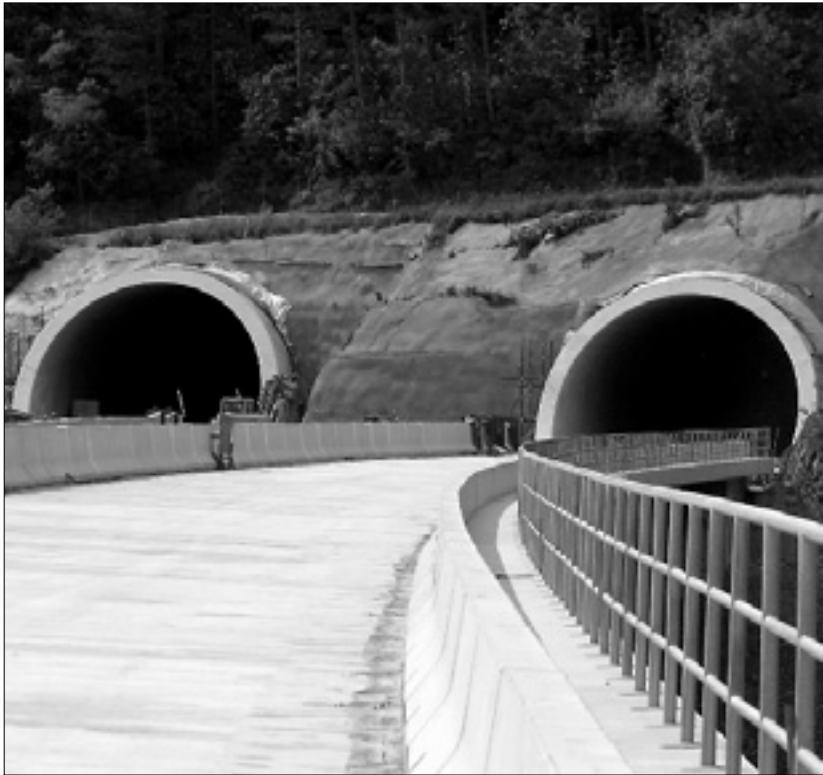
Tunela na gradbišču hitre ceste
