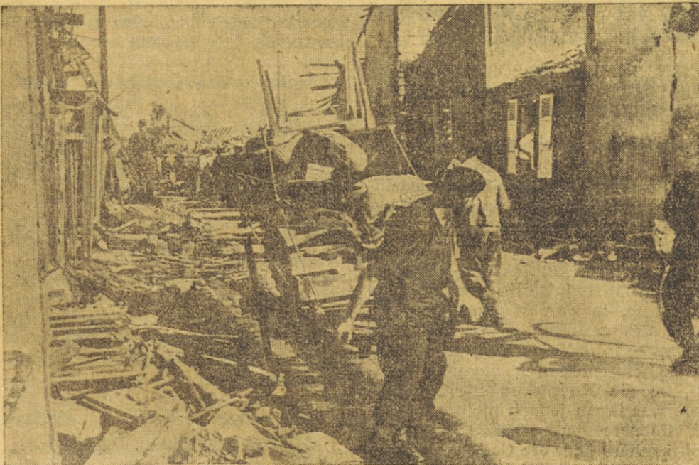
Die Bewohner der zerstörten Häuser suchen in den Trümmern nach den Resten ihrer Habe
