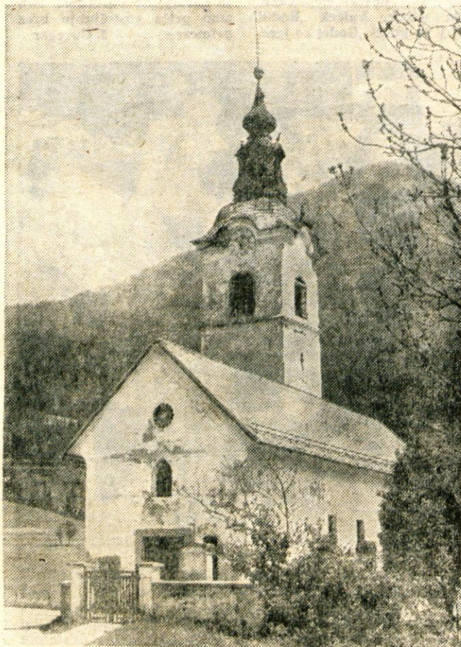
Sv. Andrej na Ravnem, podružnična cerkva na Zg. Jezerskem l. 1790 — nekdanja samostojna fara. — Foto: F. Perdan
