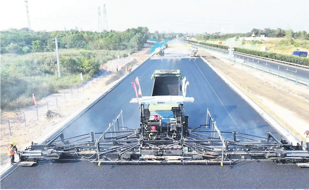
Skoraj 158 kilometrov štiripasovne avtoceste so Kitajci nedavno zgradili z minimalno človeško vpletenostjo.
