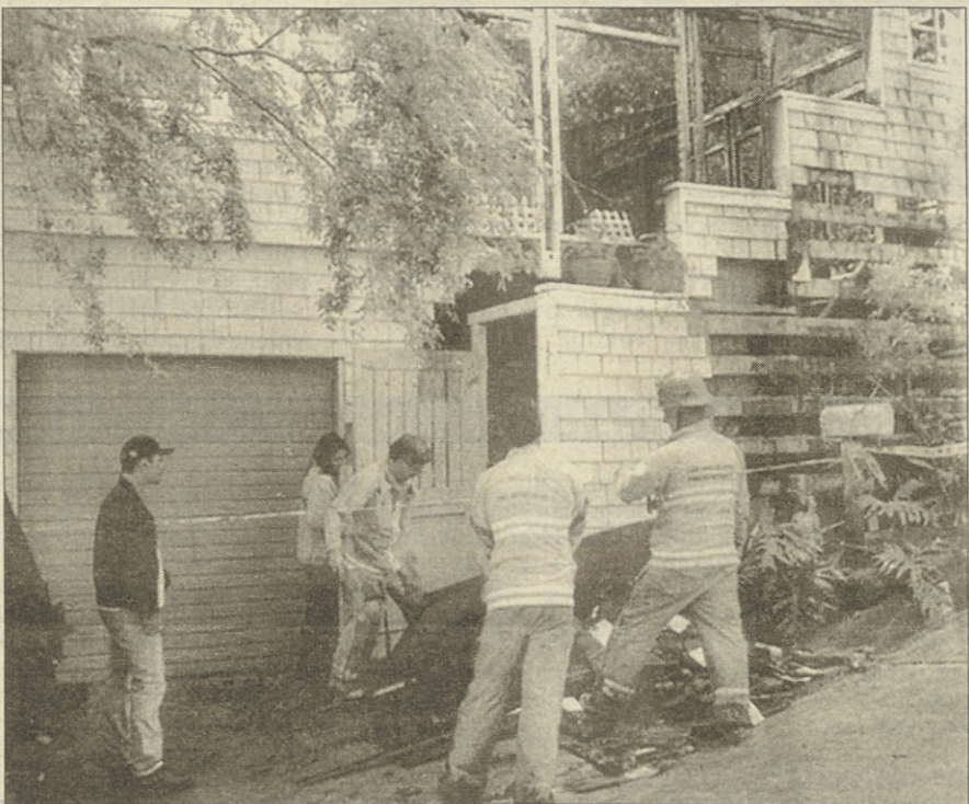
Ogenj je hišo Nine Huang precej poškodoval
