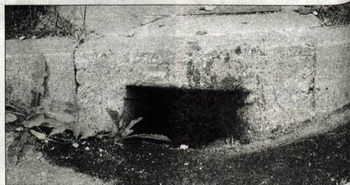
Nova velikost odtočnega kanala.
