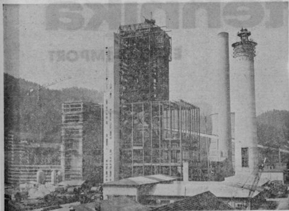
TE Soštanj — zahtevna gradnja industrijskega objekta
