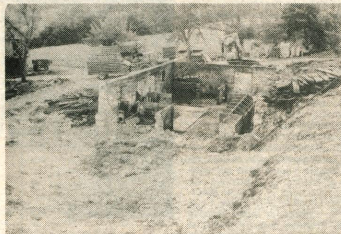
Slika pogorišča je hudo žalostna. V torek so stali le še ožgani zidovi Medjevega hleva, vse ostale ruševine so stroji Gradbenega podjetja Bohinj že odstranili. Komisija, ki je ocenjevala pogorišče, je sklenila podreti tudi Medjev hlev, kajti s prežganimi stenami si ne morejo prav nič pomagati. Nov hlev bo zahteval tudi novo notranjo ureditev. — Foto: D. Dolenc
